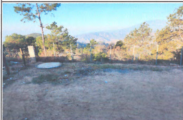
Foto 4: Mejoramiento de la losa de patio
