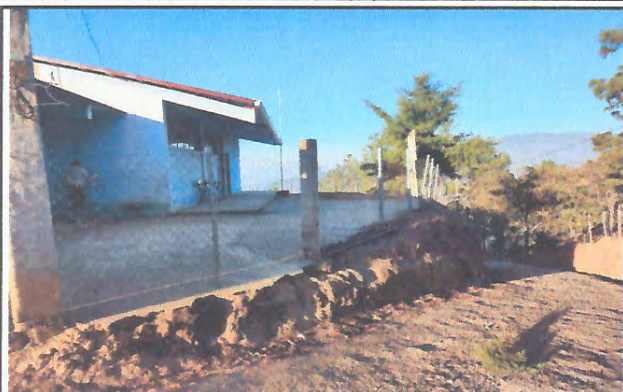
Foto 1: Mejoramiento del cerco perimetral
