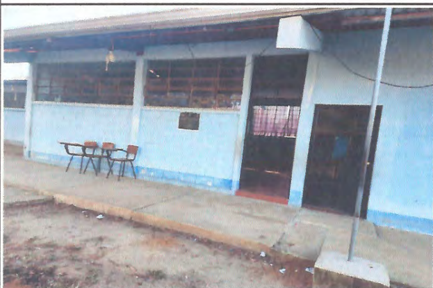
Foto 3: Mejoramiento de la pintura de los muros de la escuela
